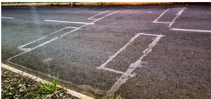
Figura 4: Marcações dos sensores eletromagnéticos sob o asfalto
