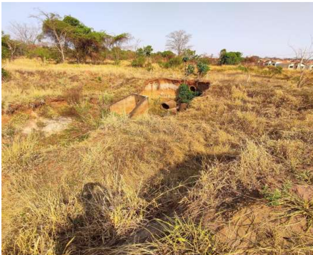
Figura 5: Boca de lobo na cabeceira da voçoroca
