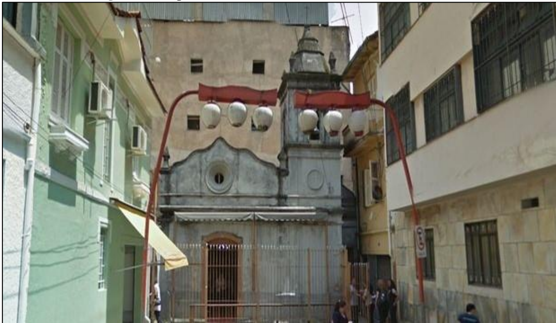
Figura 3: Capela Nossa Senhora dos Aflitos, Liberdade/SP
