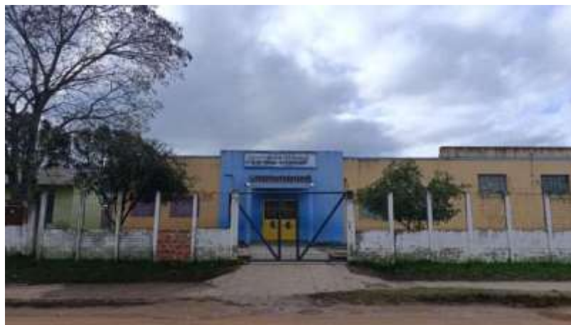
Imagem 01: Fachada da Escola Municipal de Ensino Fundamental Dr. João Thiago do Patrocínio. Fonte: As autoras.
