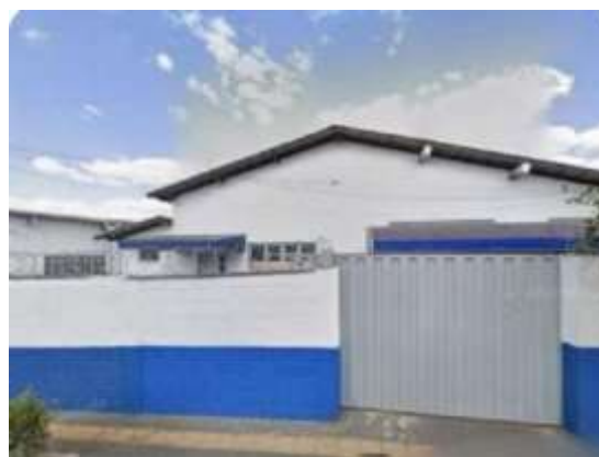
Fachada principal da EMEI. Fonte: Arquivo EMEI Diretora Maristela Gomes de Souza.
