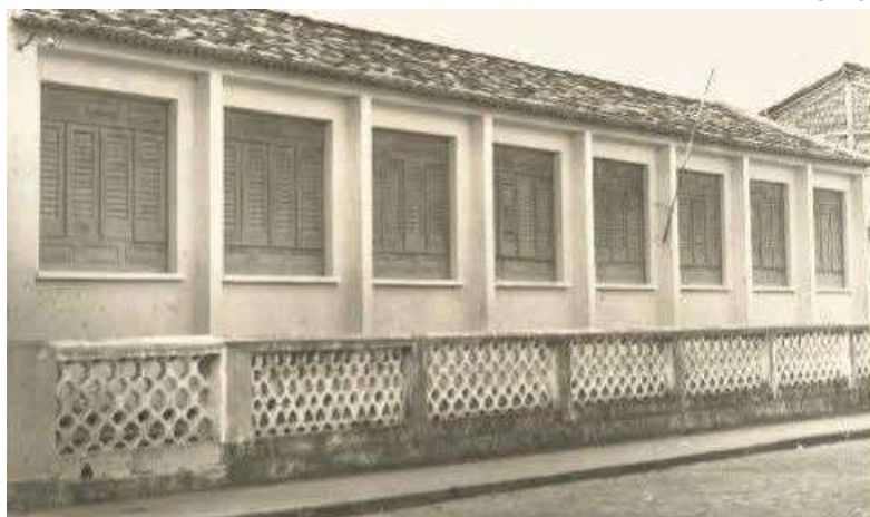
Prédio escolar onde foi instalado o CEMMO, ano de 1970
