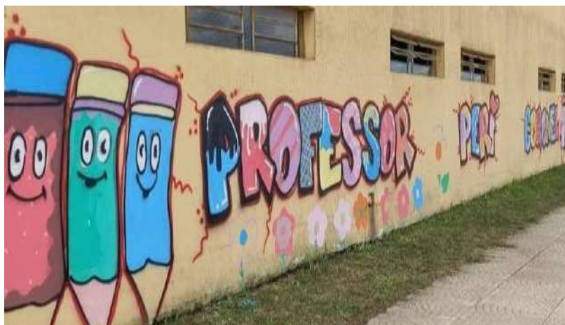
Fachada da escola em 2025. Fonte: Acervo da escola.
