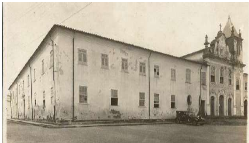
Antigo edifício do Lyceu Provincial da Bahia, Salvador.
