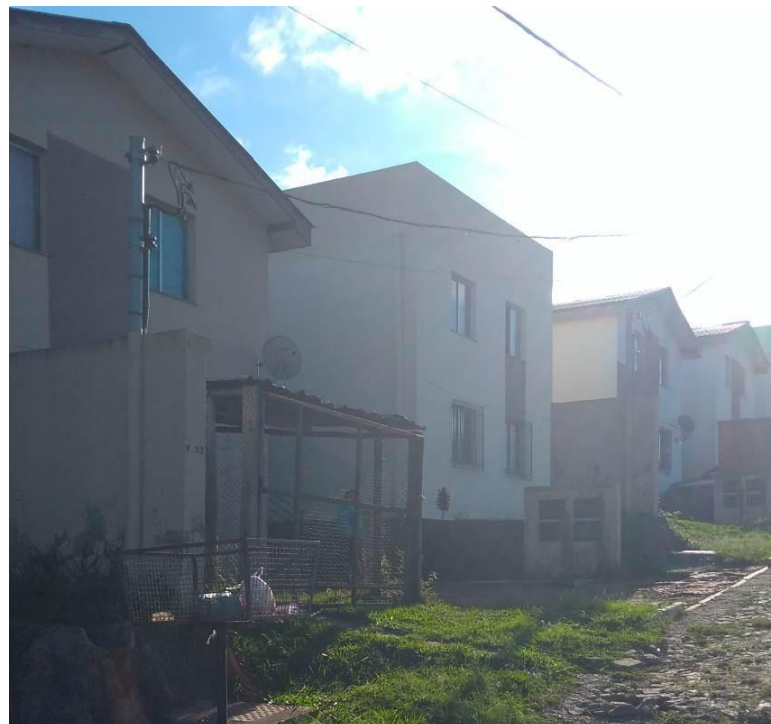
Figura 2 – Sobrado com telhado modificado Fonte: FERREIRA (2017a)
