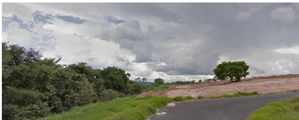
Figura 2 – Construção de loteamento próximo a mata ciliar.
