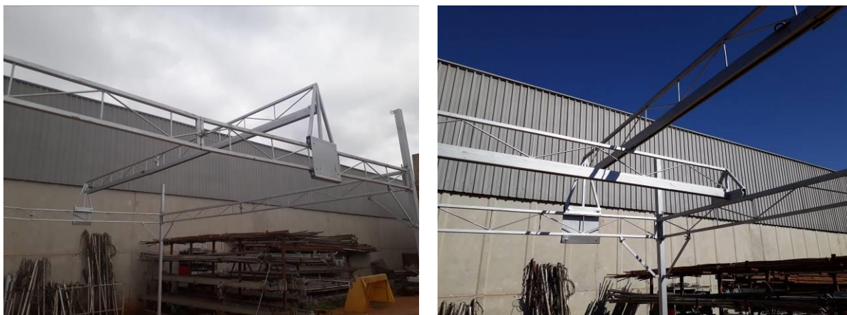
Figura 8 – Protótipo metálico inicial com estrutura treliçada.
